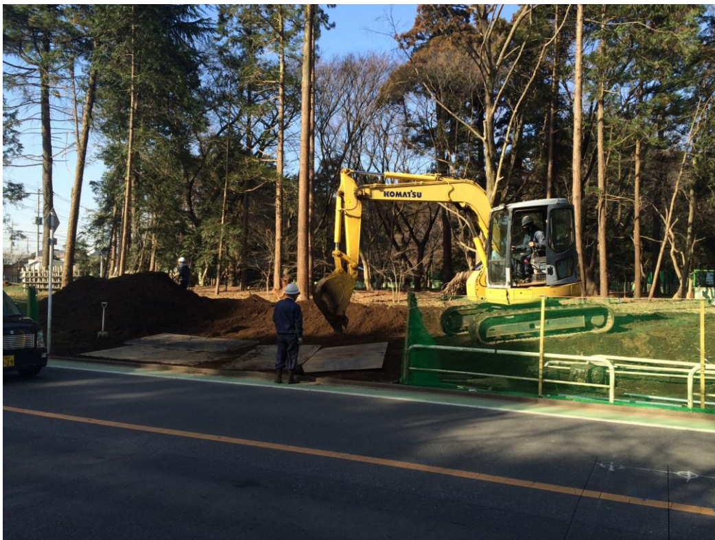
図 4 2 平林寺周囲の散策路整備工事の様子
